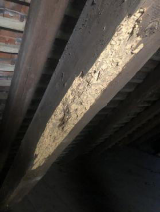
beschädigte Daachkonstruktion
