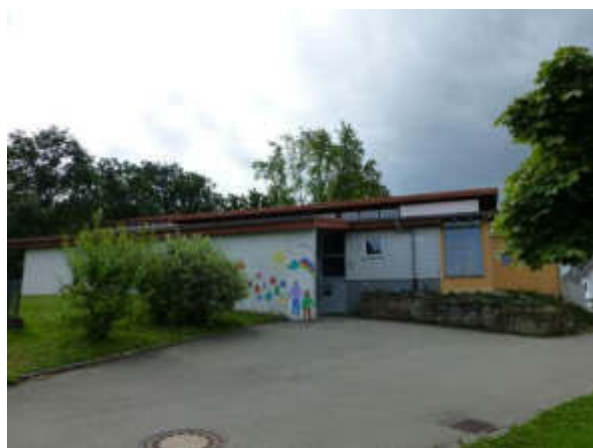
Blick von Westen nach Osten (4.4.3)
