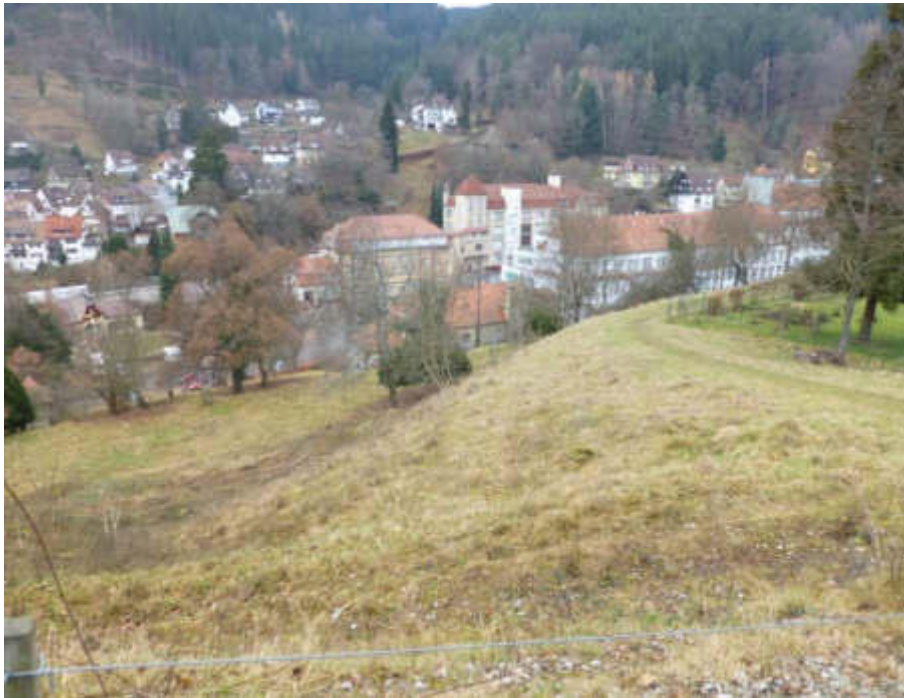
Abbildung 7: Ansicht von Süden
