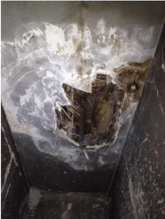
Decke durchgebrochen
